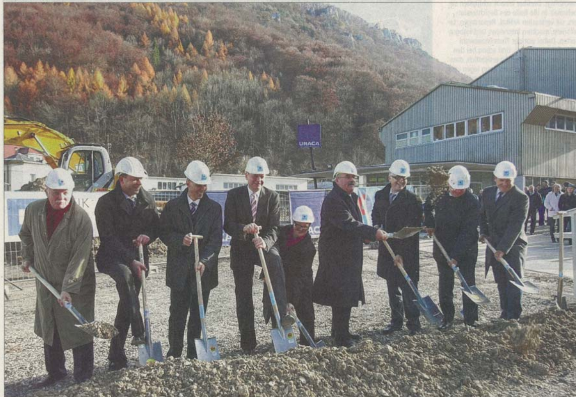
Projektstart mit dem symbolischen Spatenstich: Wolfgang Maier, Geschäftsführer der Firma F. Kirchhoff, Carsten Weiss, Entwicklungsleiter Uraca, Uraca-Geschäftsführer Gunter Stöhr, Wolfgang Epp, Hauptgeschäftsführer der IHK Reutlingen, Anja Dobler, Leiterin des Amts für Umweltschutz am Landratsamt Reutlingen, Uraca-Geschäftsführer Johann Amon, Architekt Helmut Hirth, Bürgermeister Elmar Rebmann und Robert Zimmermann, Produktionsleiter Uraca. Foto: Thomas Kiehl
