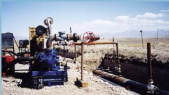
管道和管材压力测试
