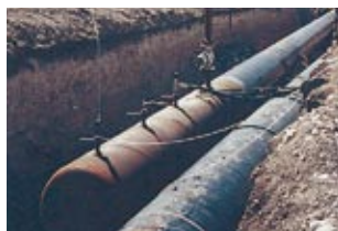
■ Испытание давлением, например, нефтепроводов
