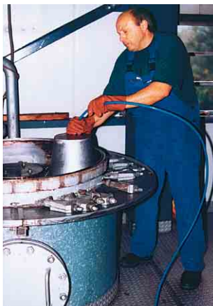
Limpieza manual de un intercambiador vertical con manguera flexible y campana para protección contra salpicaduras.
