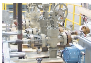
Рис. внизу: Агрегаты впрыскивания метанола на оффшорной платформе в Северном море. Производительность подачи: 2x45м 3 /час Рабочее давление: 370 бар Мощность: 2x570 кВт
